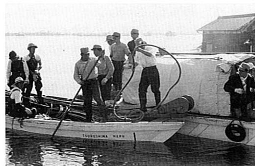
▲伝馬船に应急ケーブルを積込み、作業艇で曳航敷設中。
