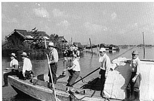
▲見わたす限り水と家屋、微速でケーブルを敷設しながら進む、作業艇。
