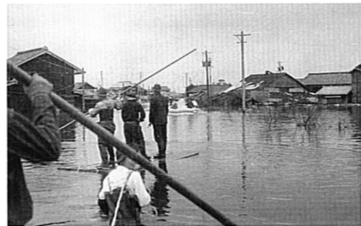
▲冠水した道路らしき所をケーブルを引っ張って行く乗組員。(筏に乗り弥富より敷設開始)
