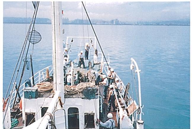
▲故障ケーブル巻揚げ。
