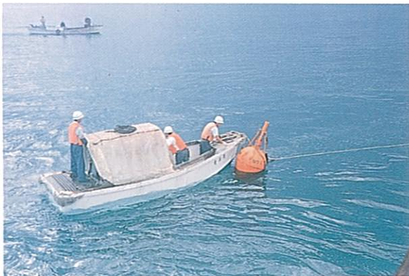
◀ケーブル線端に付けたブイを収容する作業艇。
