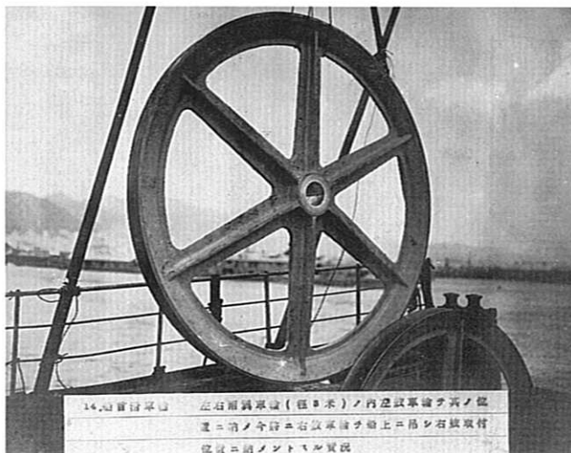
▲船首シーブ車輪(直径3.0m)
