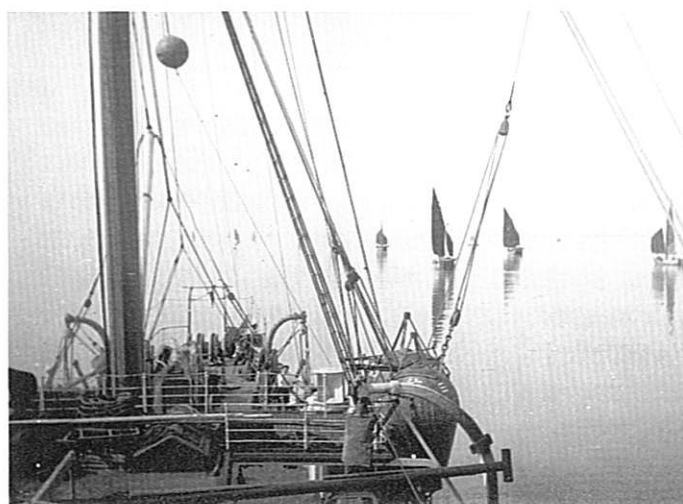
▲昭和11年1月～2月、上海南木道をケーブル敷設中の沖縄丸。 ジャックの間をぬうようにケーブルを敷設する。
