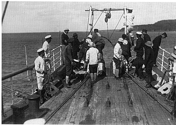
▲ 船首作業甲板上的作業風景。工事部員と本船乗組員の作業服に大きな相異がある。ケーブルの接続を終え、最終沈下作業中。
