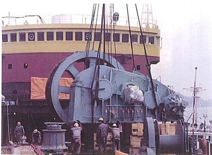
▲左舷ドラム積込中。 (ドラム直径3.8m、捲揚能力30トン)
