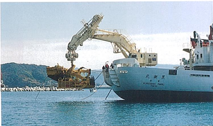
◀昭和61年6月、八戸～苫小牧間 有中継光ケーブル敷設埋設工事 のため苫小牧陸揚でP-4型埋設 機設置中。
