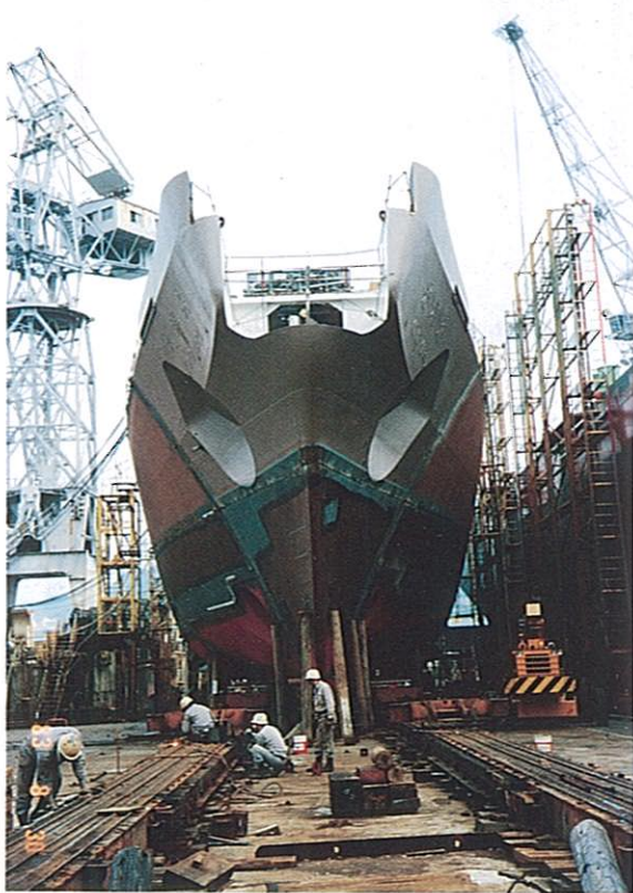
▲建造が進む光洋丸。 バウ・シーブ取付け位置が大きく口を開けている。シーブは油圧で出し入れ自由。
