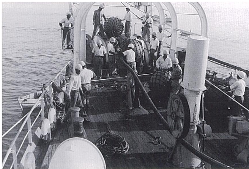
▲ケーブル陸揚作業中の船首作業甲板
