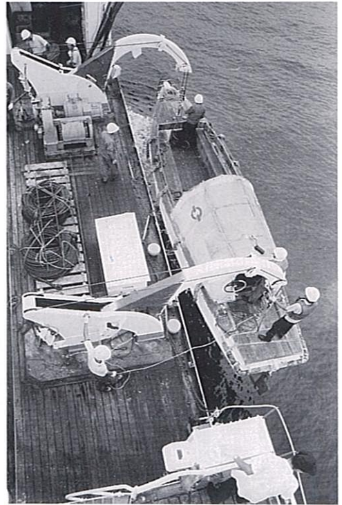
▲作業艇ダビット(重力式)
